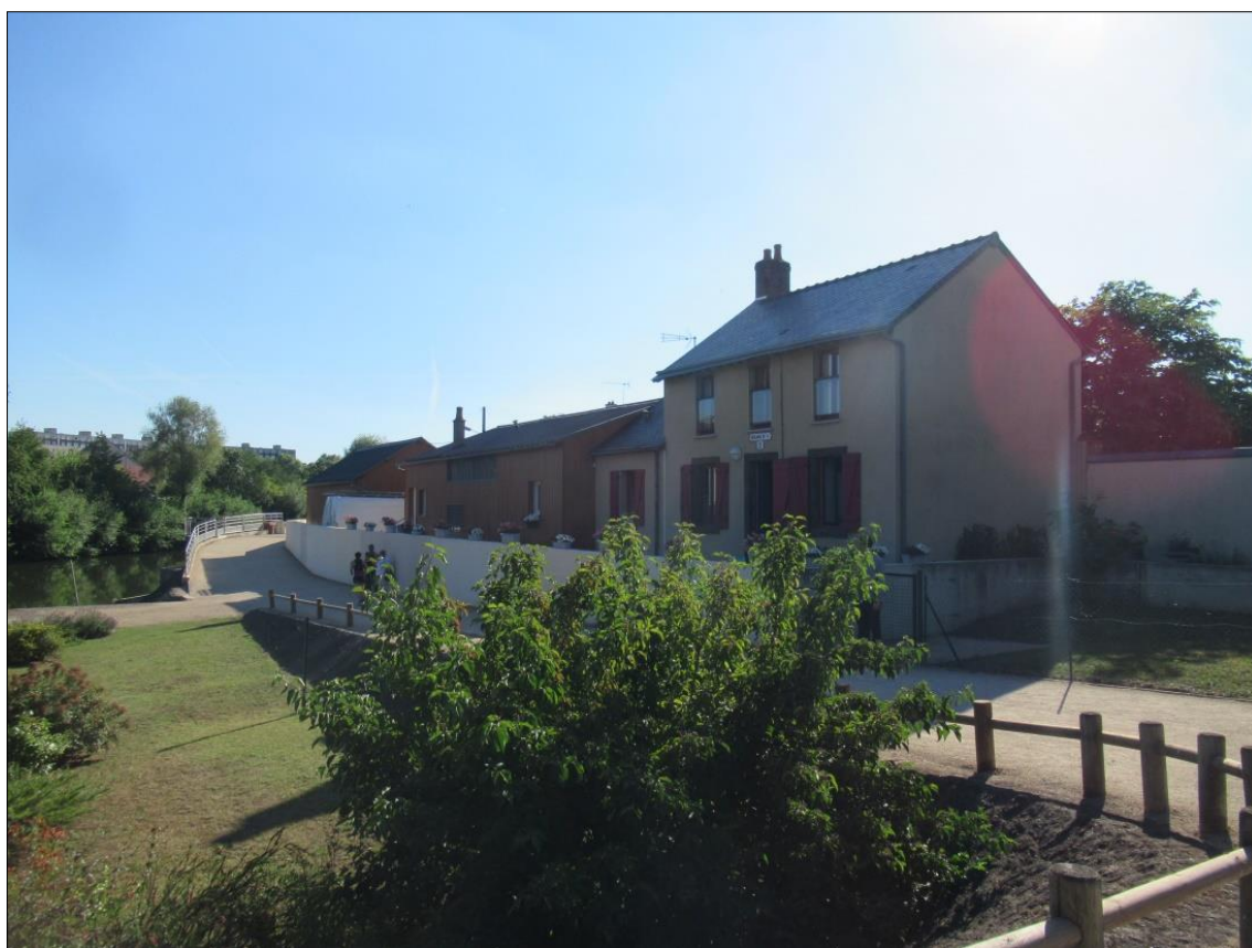
Site des Planches
