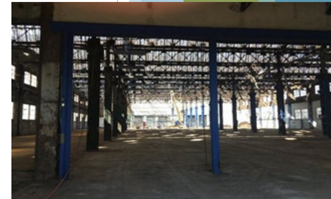
Lunéville : Chantier de désamiantage de la friche Trailor pris en charge par l'EPF Lorraine, pour le compte de la communauté de communes du territoire de Lunéville à Baccarat.
