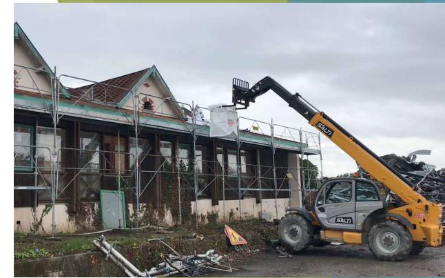
Orthez : Chantier de démolition des bâtiments de l'ex-papeterie des Gaves, sous la houlette de l'EPFL Béarn-Pyrénées, propriétaire de la zone, qui dirige les opérations pour la communauté de communes de Lacq-Orthez (CCLO).
